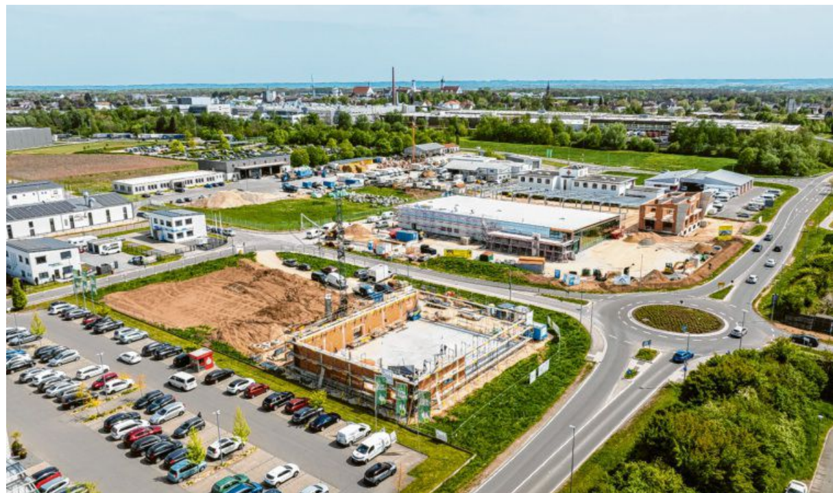
Hier in der Josef-Krätz-Straße 1 im Dillinger Gewerbegebiet Siemensstraße entsteht der Neubau der Firma Bacher. Fotos: Jan Koenen, Stadt Dillingen; Berthold Veh (2)
