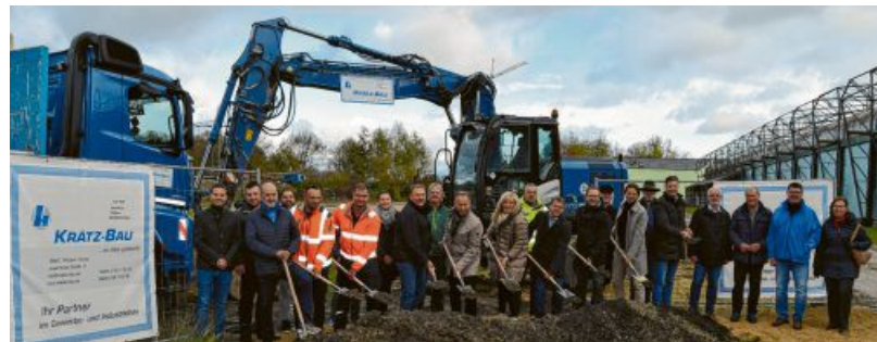
Der Spatenstich für den Bau eines neuen Gebäudes auf dem Gelände an der Donauwörther Straße. Foto: Ulrike Hauke
